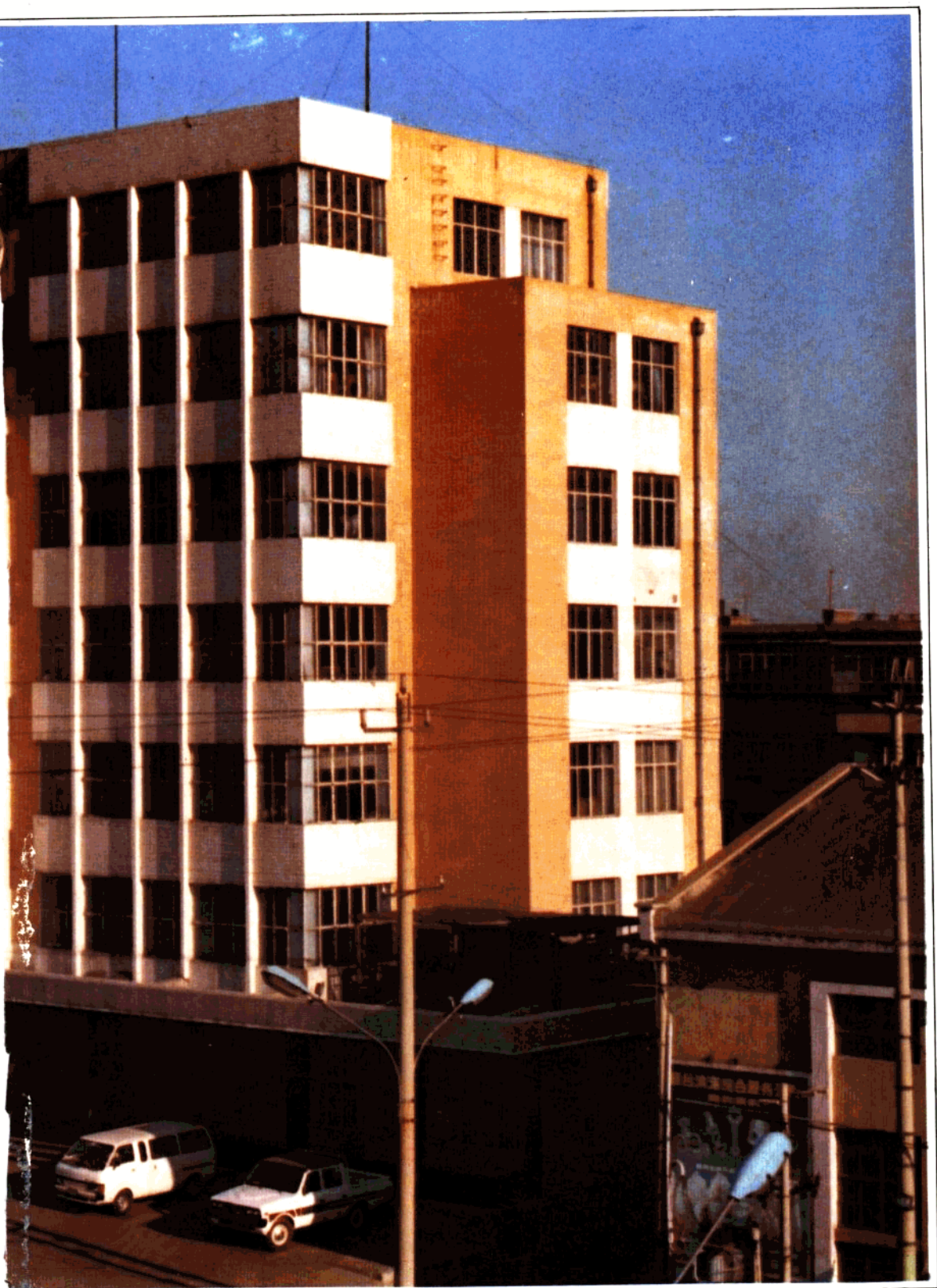
烟台市保险分公司办公大楼
