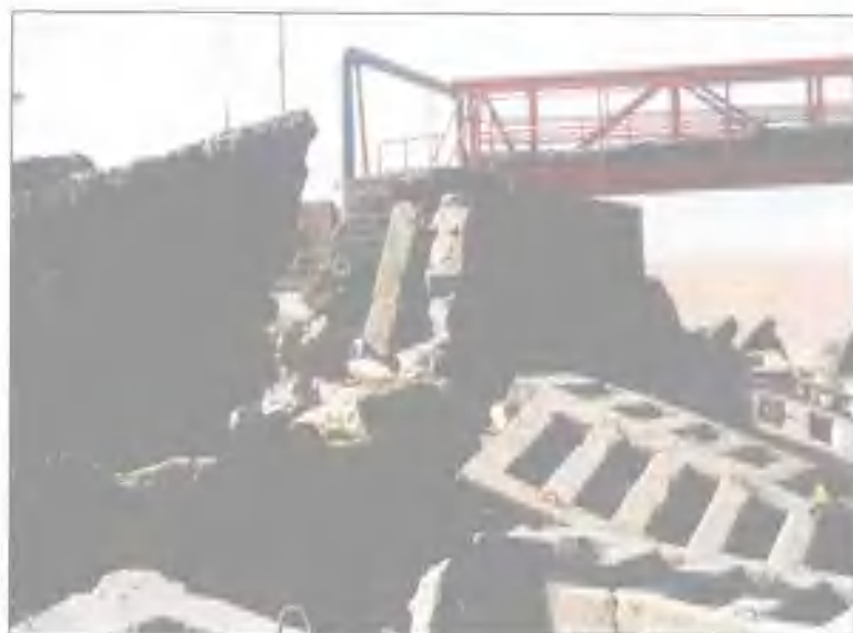
图 6 受“10.11”温带风暴潮影响黄河海港附近海堤被损
