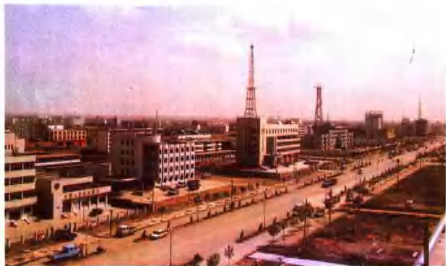
蓬勃发展的城市建设
