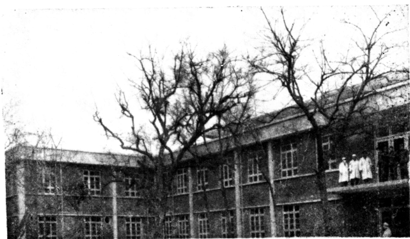
内黄县人民医院病房大楼
