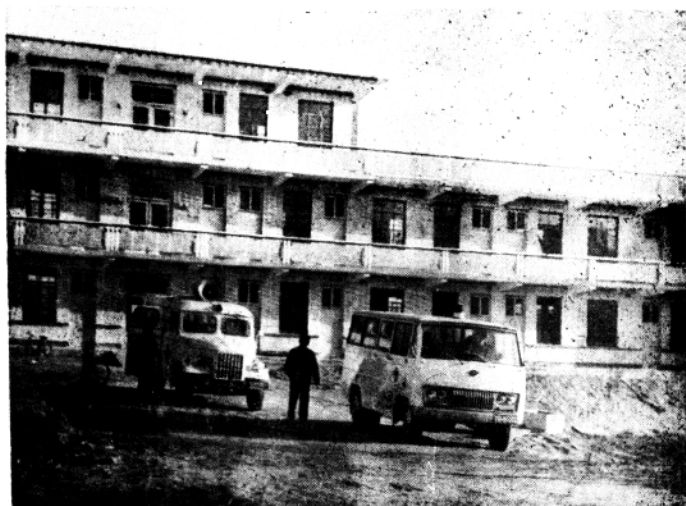
内黄县卫生防疫站办公、检验大楼
