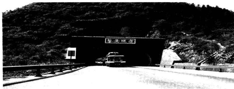
贵遵高等级公路黎安隧道
