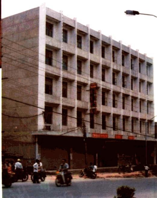
晋江市医药公司办公大楼
