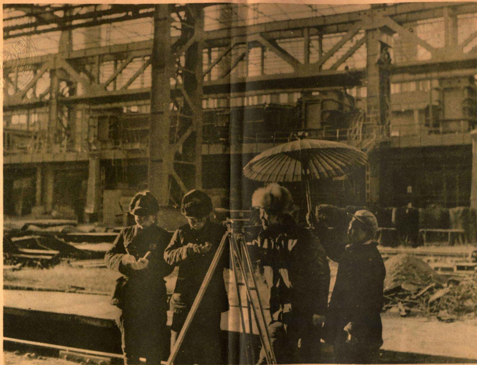
2 測量工作人員在新建的廠房內測量怎樣安裝近代化、自動化的機器。
