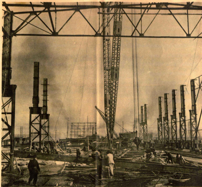
9 每個新建廠房的數百排鋼架，經過專業性的金屬結構工程公司加工後，由三十噸的大型起重機進行架設，因而使工人們減少了笨重的體力勞動。
