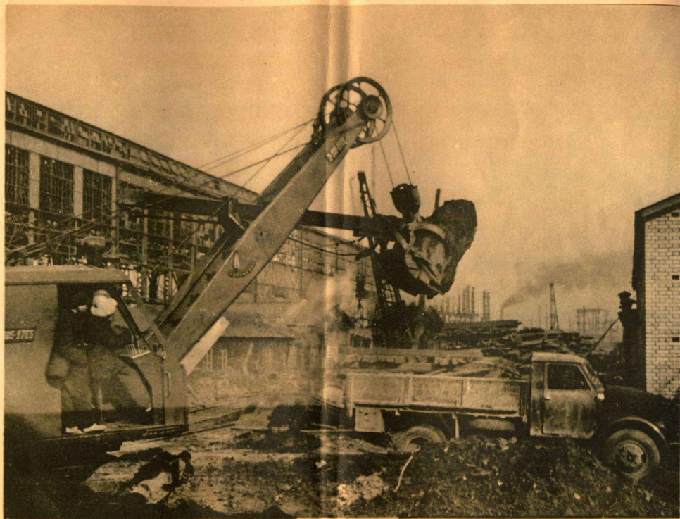
6 在鞍山基本建設工程工地上挖土的自動挖土機。
