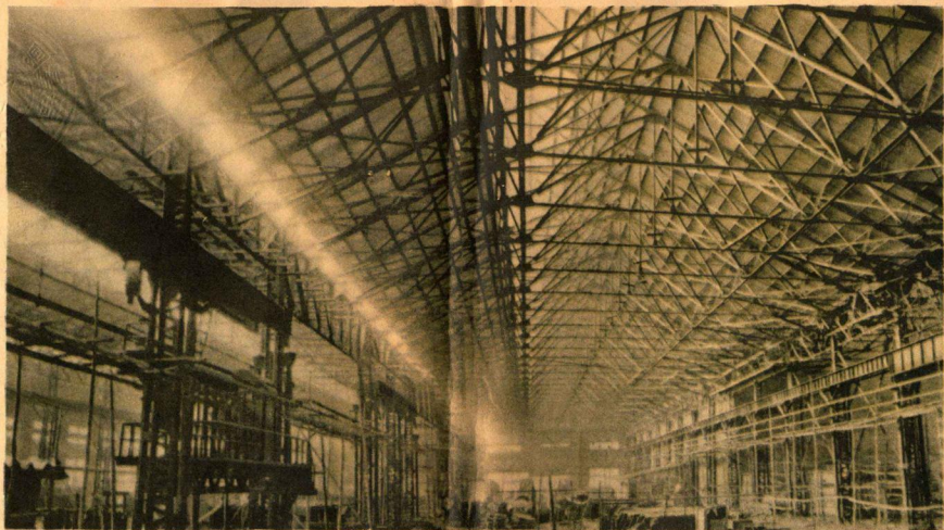
1 鞍鋼大規模的基本建設開始後，將出現許多高度機械化、自動化的新型工廠。這是某工程第一廠廠房內景的一角。
