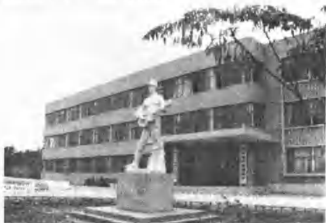
图为新浦磷矿后建的办公室
