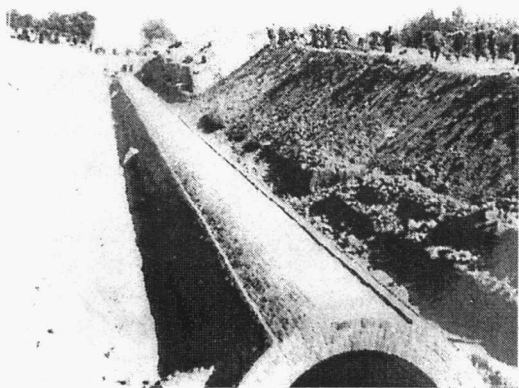
图2 龙须沟下游拱沟正待还土
