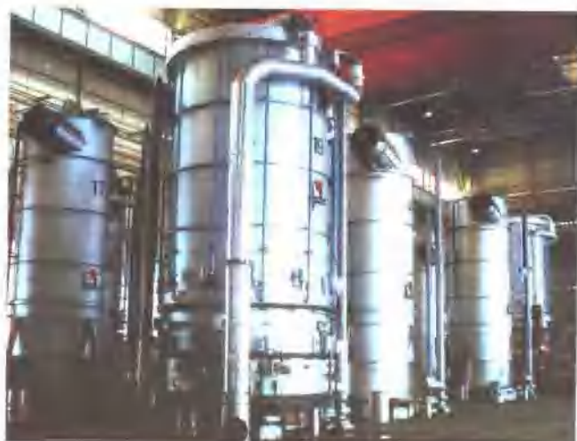
6月6日，主要由冶建机电公司安装施工的冷轧厂新增九座全氢罩式退火炉正式投产。
