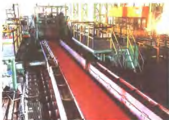
3月5日，以精轧机交交变频和SVC无功补偿为主的热轧二期改造恢复生产，一次性过钢成功。
