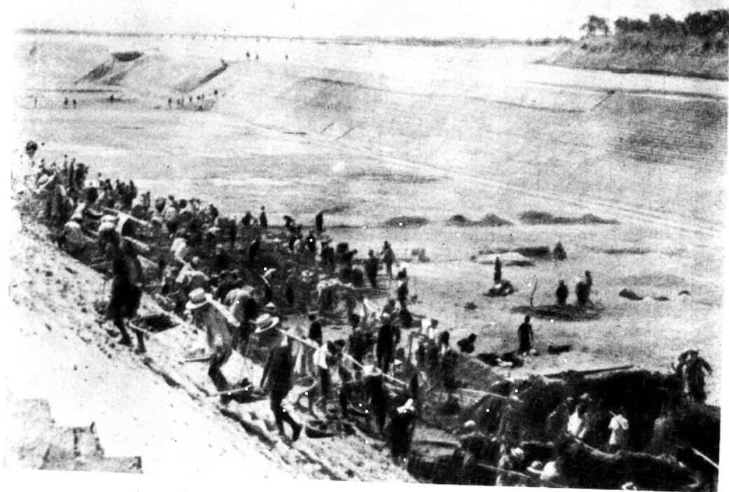
入江水道第一期工程——六閘附近切灘及鳳凰河 拓寬于今年开工。图为鳳凰河拓寬工程一个工段。
