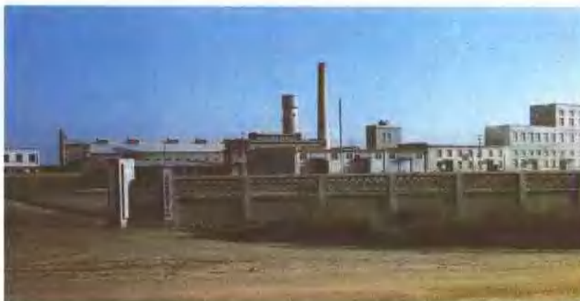
高岛盐场化工车间
