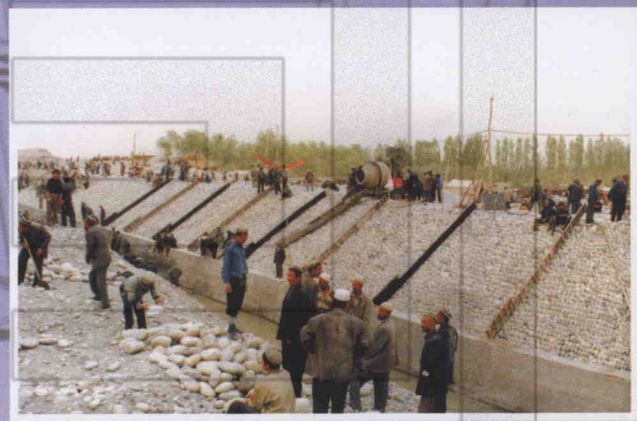
修建防渗大坝
