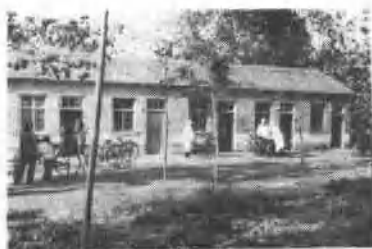
水池铺卫生院 (1—35)
