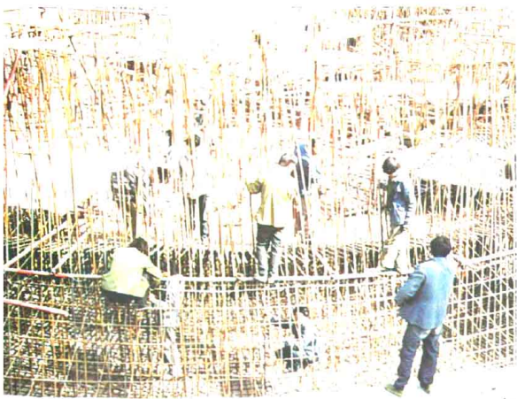
一号烟囱基础施工
