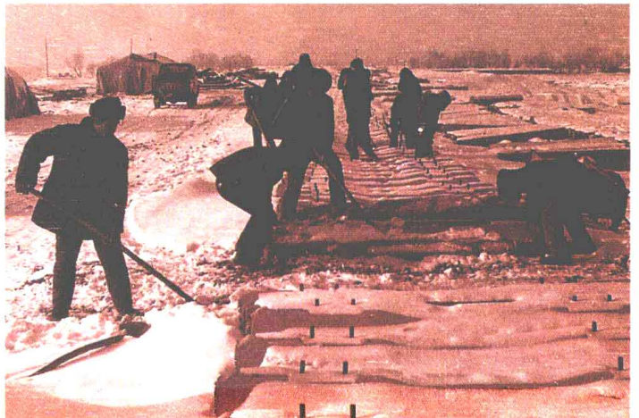
铁路专用线施工现场
