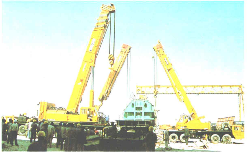
主变压器运抵工地
