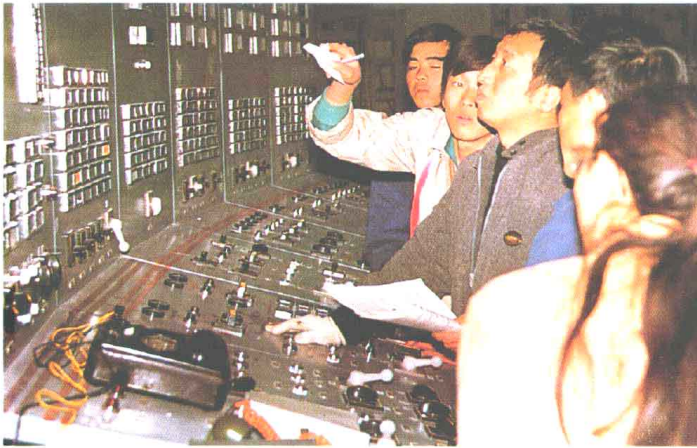
锅炉安装竣工调试
