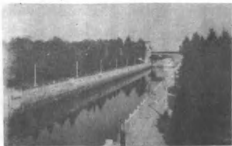
京杭运河上的解台闸
