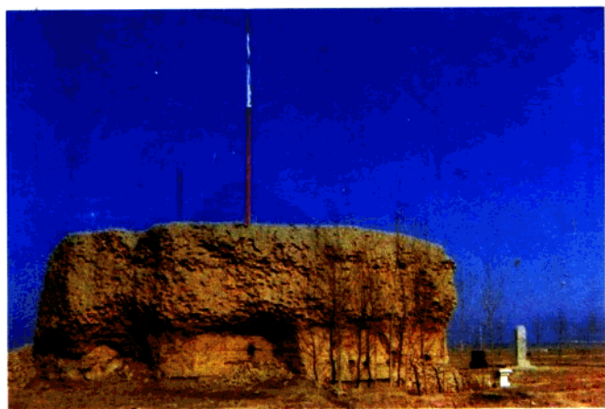
萨迦班智达·贡噶坚赞灵骨塔基
