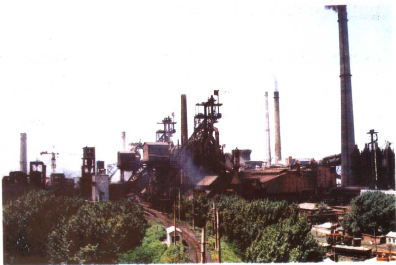
本钢二铁厂高炉群
