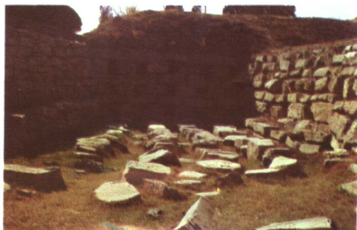
齐故城排水道口
