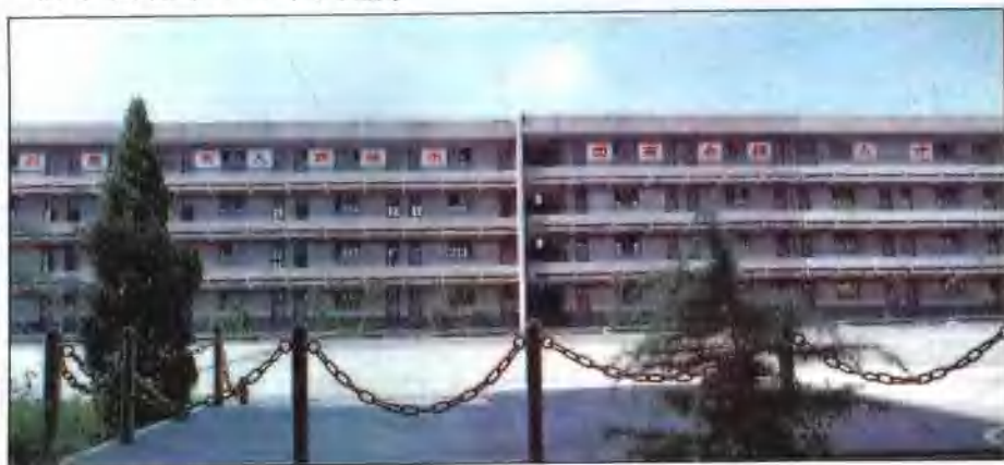
教学大楼 (1981 年兴建)
