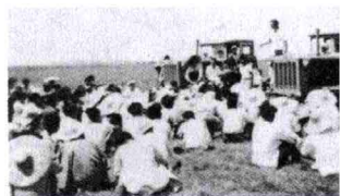
方敬之在工地
