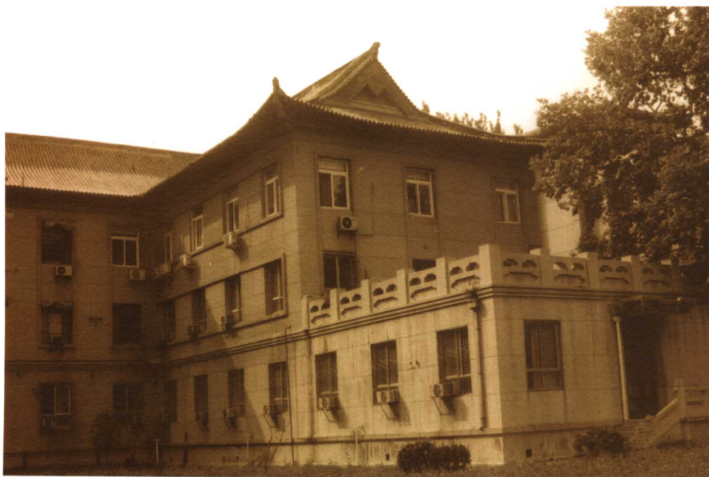
河南省人民医院门诊楼
