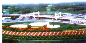
平东高速公路立交桥
