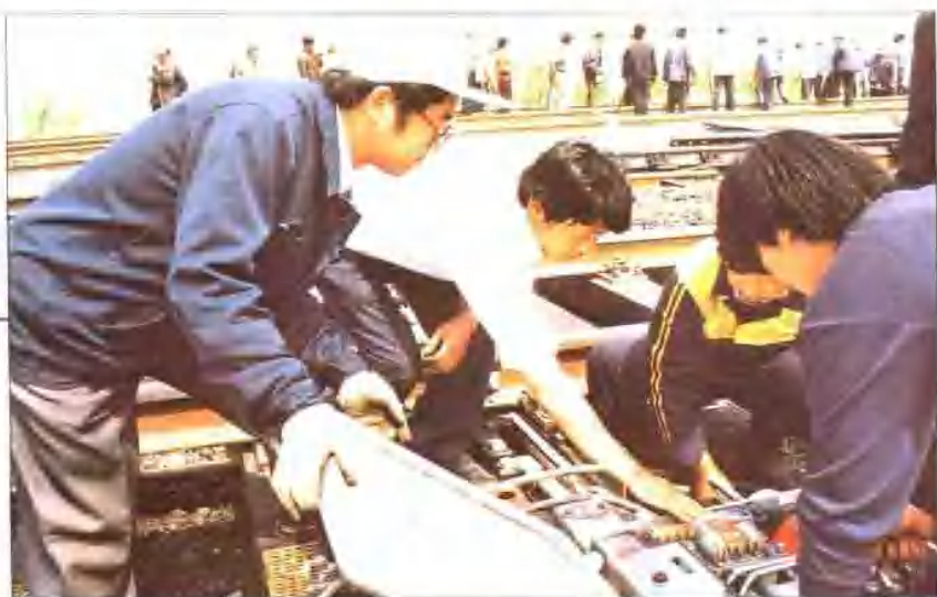
丰润电务段施工小组施工后对设备进行复验
