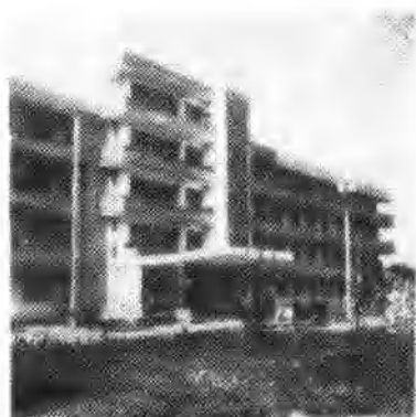
邓县人民医院病房大楼
