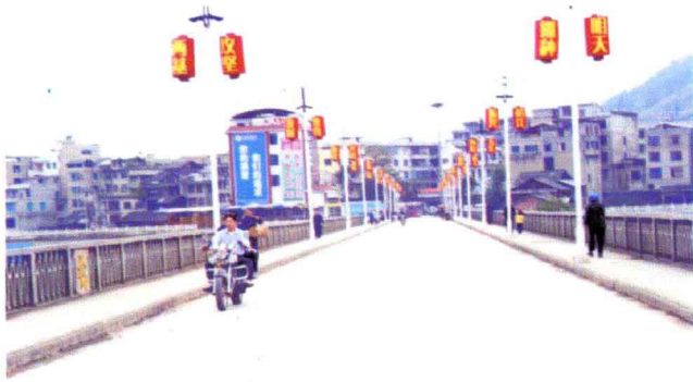
2006年维修一新的榕江大桥南端
