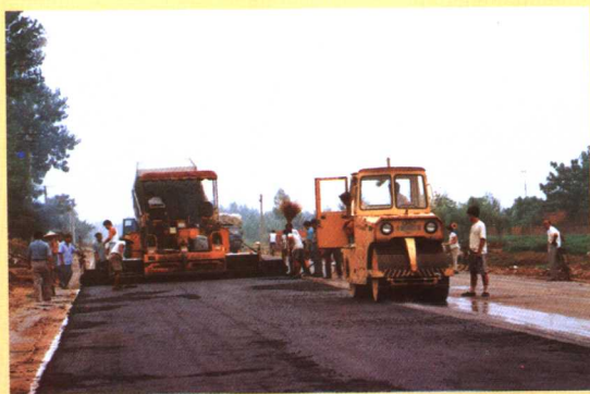
2000年8月，正在进行沂胶路井沟至田庄段的建设。
