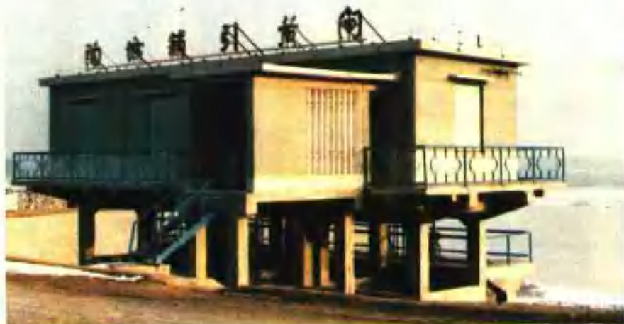
陶城铺引黄灌区渠首闸
