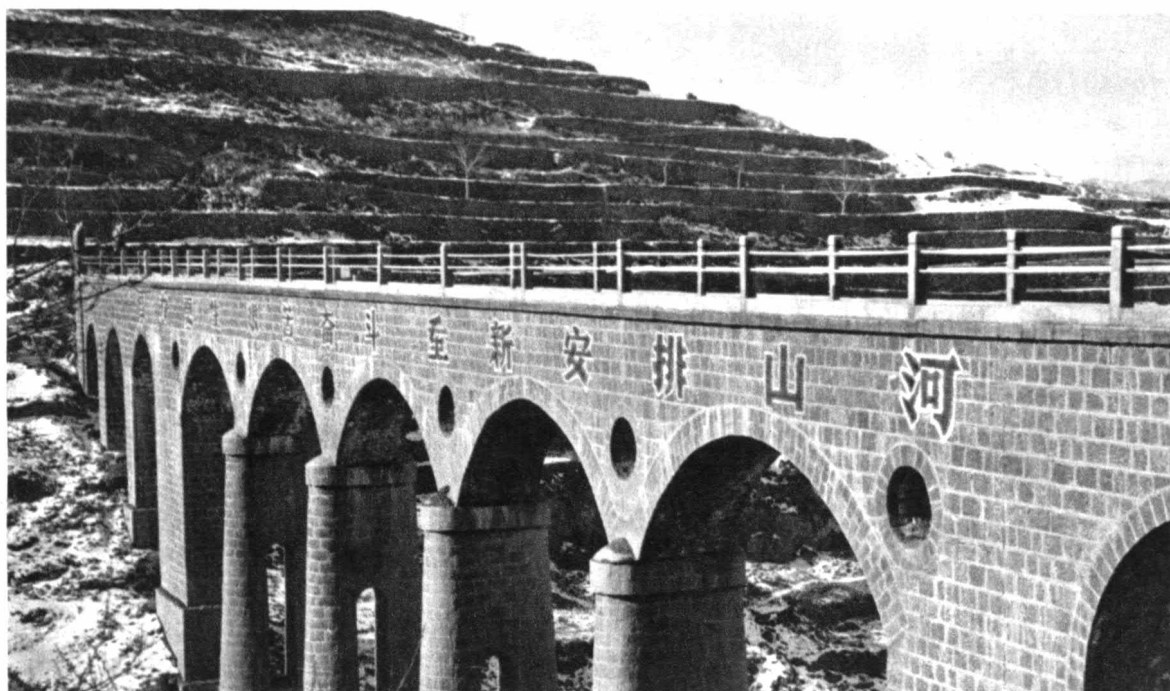
大寨团结沟渡槽
