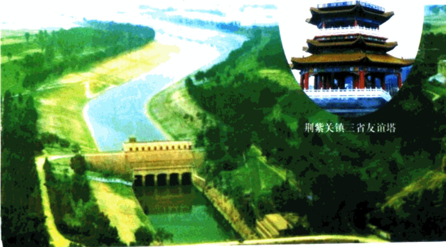
南水北调中线工程渠首——九重陶岔
