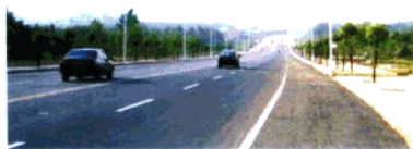
县城东环路（全县油路由1997年的12公里发展到2003年的360公里，建水泥路68公里）
