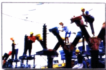
电建职工紧张施工
