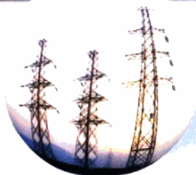
武当山水电站
