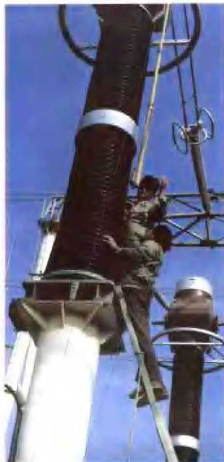
13. 对构架上的电气设备进行测试
