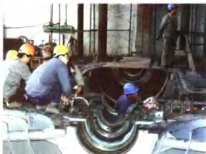
8 在遵义发电厂12.5万千瓦机组的安装现场
