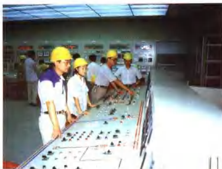
7 在清镇发电厂进行20万千瓦机组的整套启动试验
