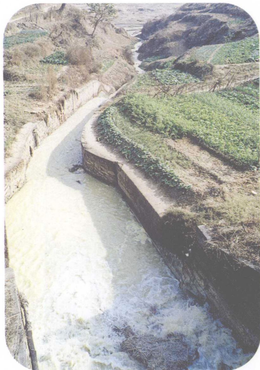
流向唐河的排污渠
