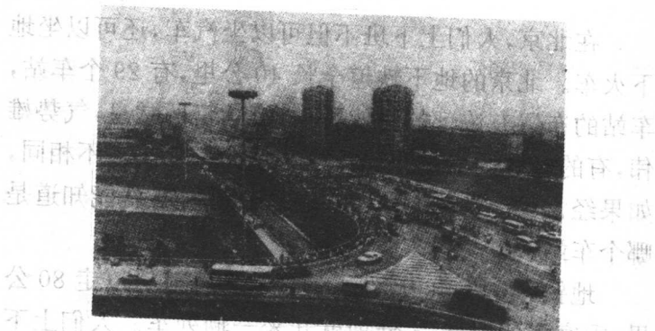
新建立交桥通车
