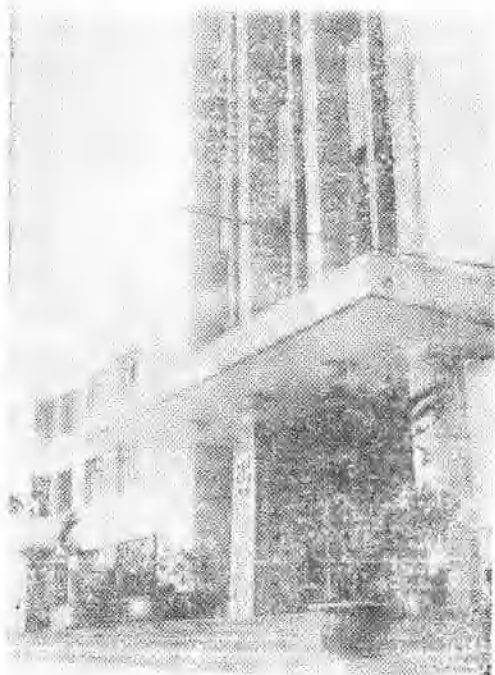
中共全椒县委办公大楼
