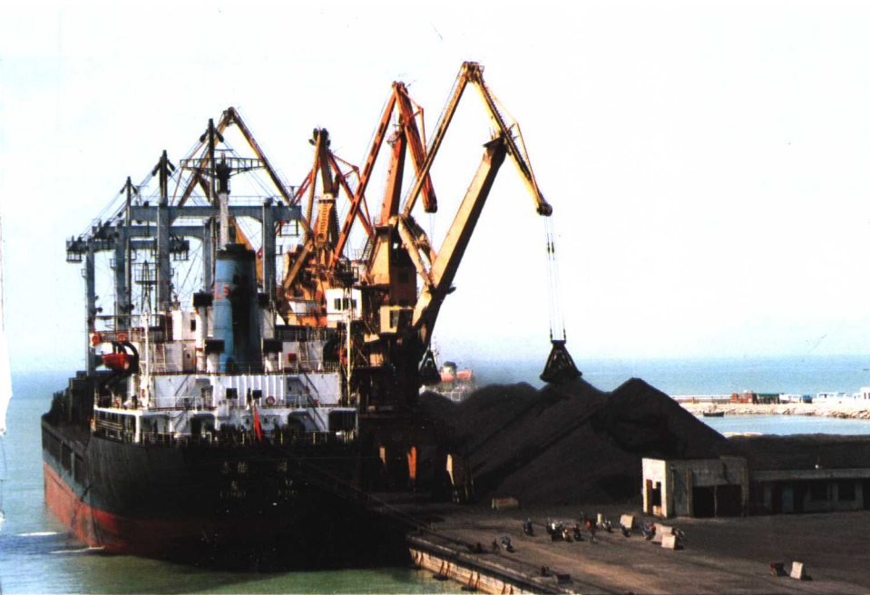
龙矿煤炭外运码头
