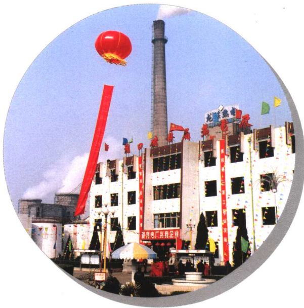
龙矿集团热电厂
