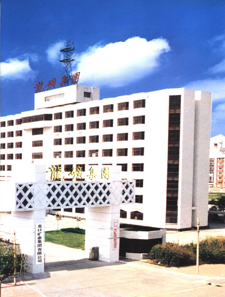
龙矿集团总部办公大楼
