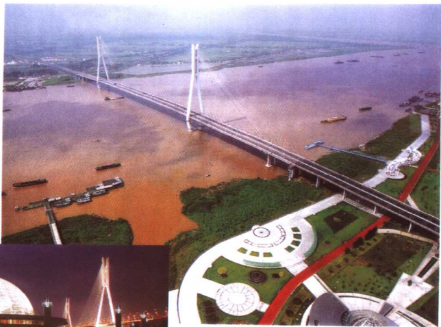
南京第二长江大桥
