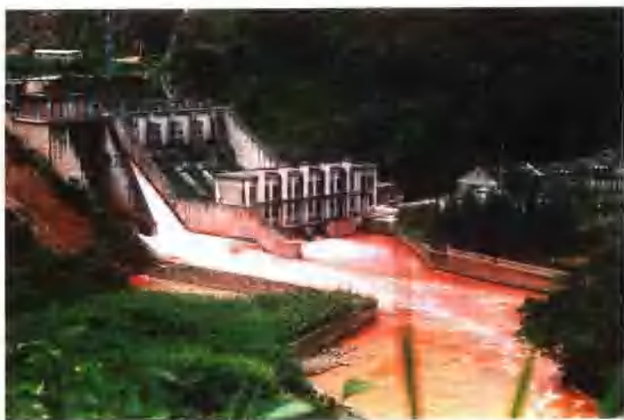
马脖子电站——建在曲江河上，是通海设计建设的最大的小水电工程。
