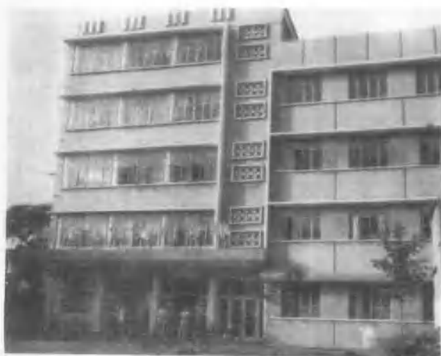
新野县公疗门诊部
