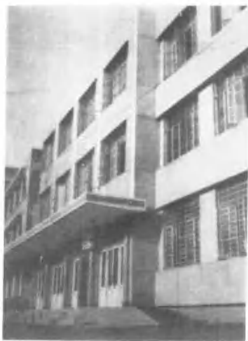
新野县妇幼保健所门诊楼
