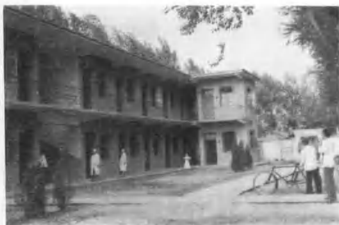
新甸铺卫生院病房楼。
