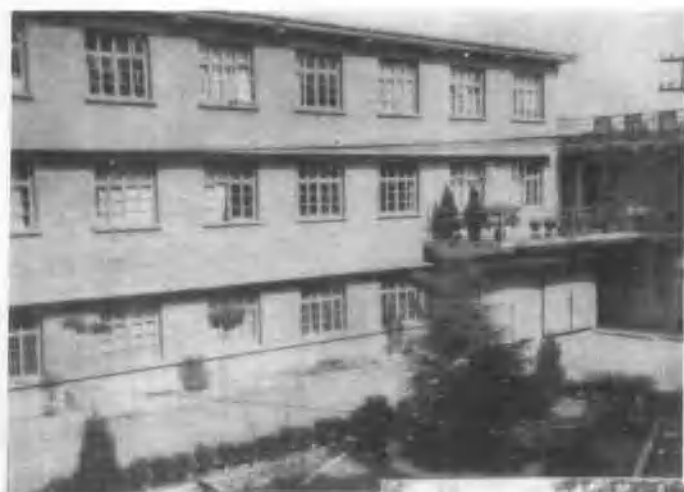
新野县卫生防疫站 办公楼
