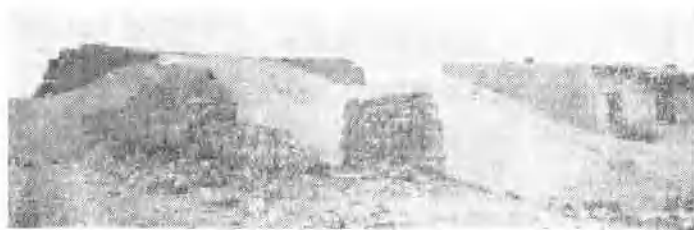
治沙前，磴口縣沙丘每年由西向東移動30多丈，不但埋沒良田，並且危害房屋。
