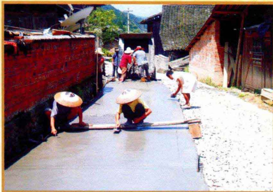
↑ 铜鼓人民正在搞步道硬化建设 杨彬 摄
