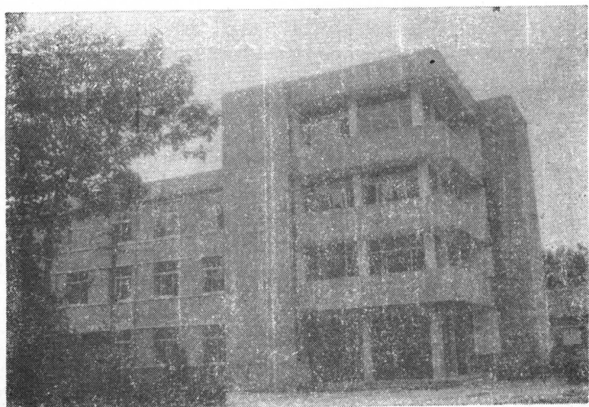
菏泽地区文化局办公楼
