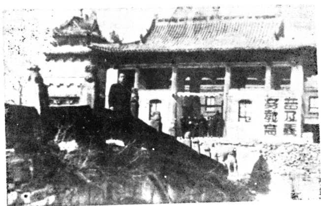
内邱县扁鹊庙桥楼
