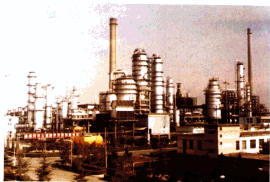
洛阳石油化工工程公司设计的年处理量 500 \times 10^4 吨炼油生产装置
