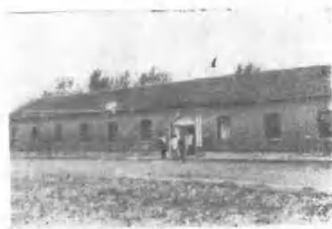
图18 商城县鄢岗乡卫生院
