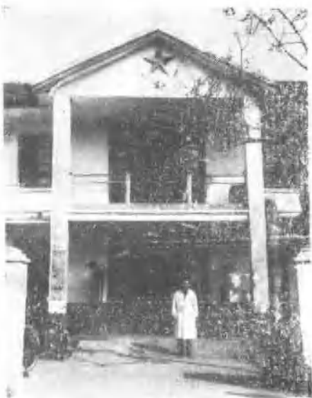
图4 商城县医院门诊部
