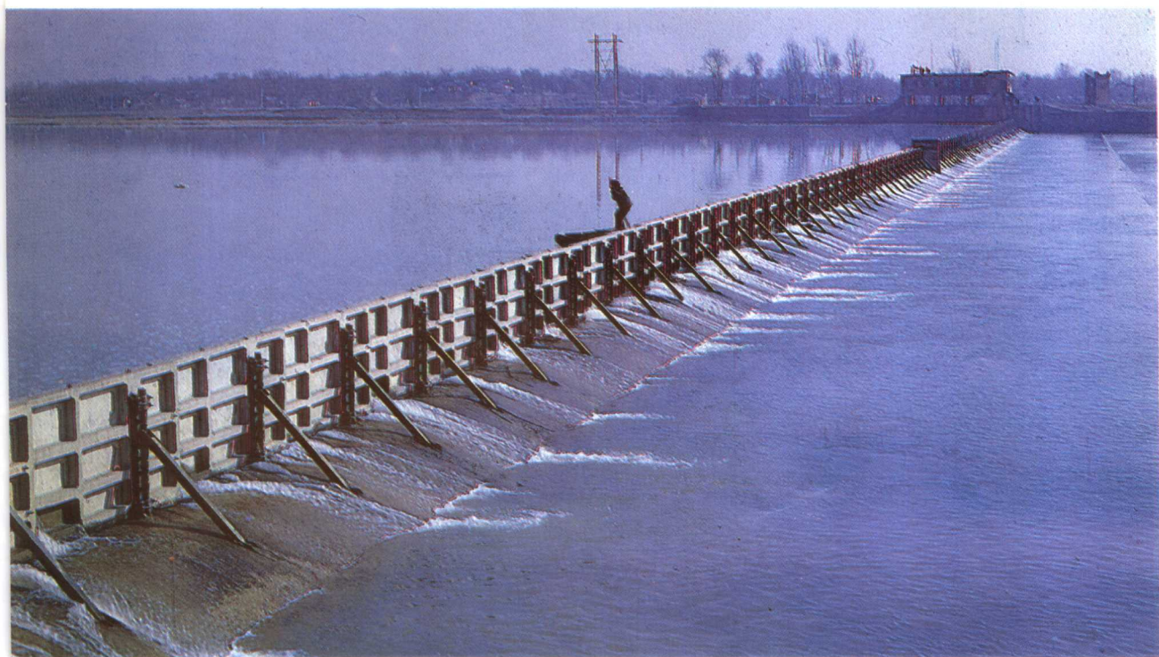
白桐灌区大占头渠首工程
