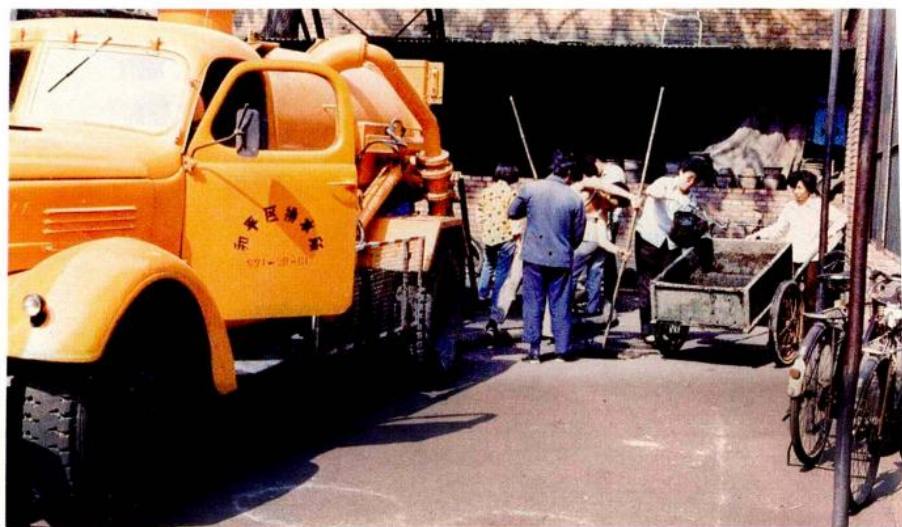
全体党员义务奉献活动，为河北路小学疏通、掏挖下水管道。
