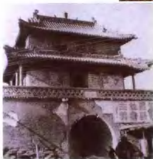
高唐县城钟鼓楼（1453年重建 1966年拆除）
