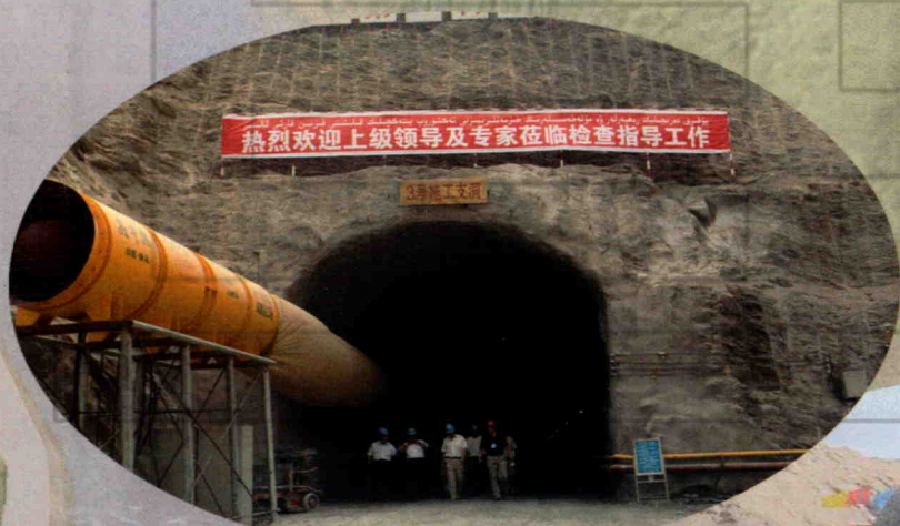
领导和专家检查指导3号支洞工程建设情况
