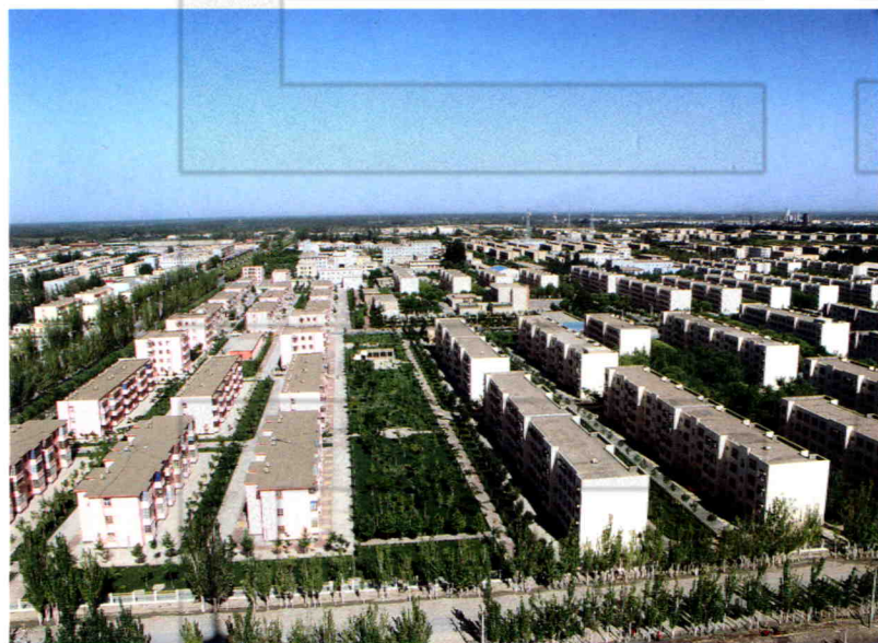
石油基地职工生活区
