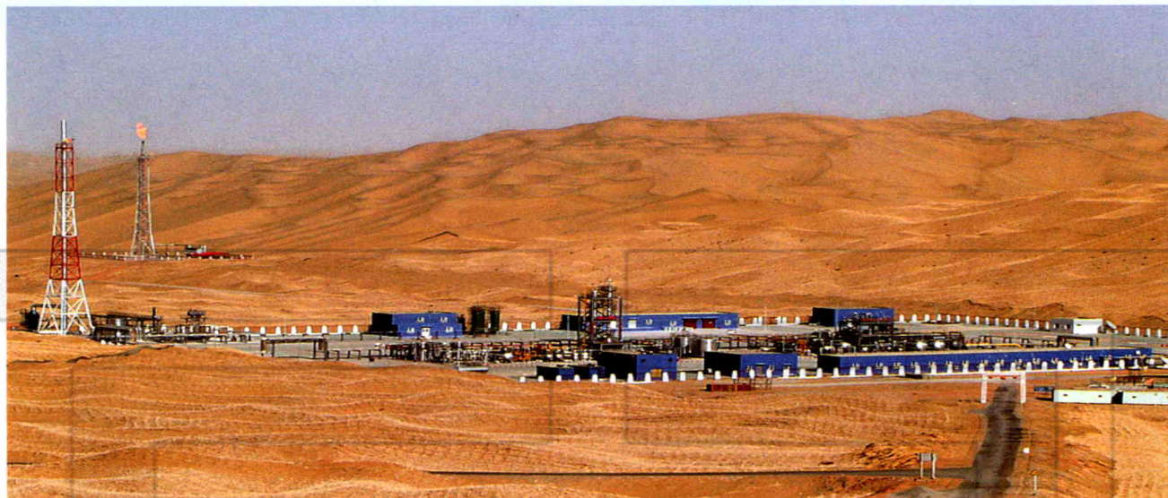
和田河气田全貌
