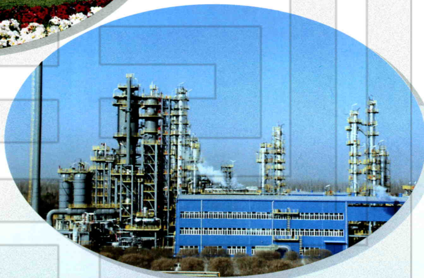
塔西南石化厂炼油技改装置正常生产的塔置远眺
