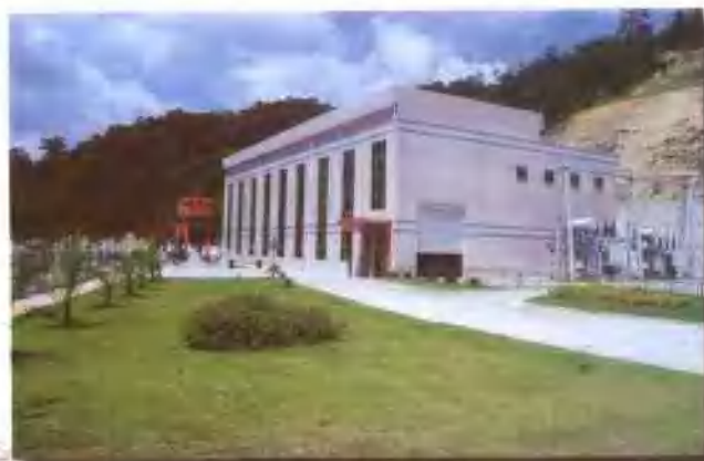
涌溪三级电站
