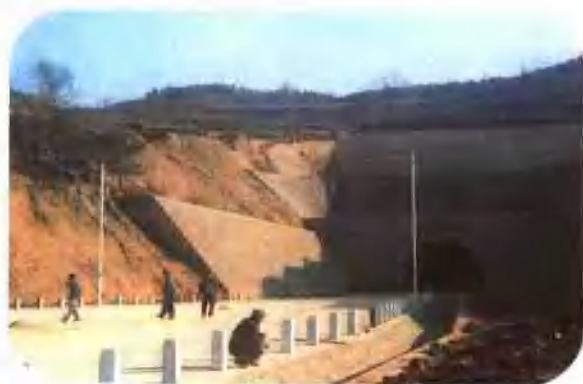
省道 304 线安口段改道新隧道
